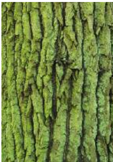
2 Algen (wie auch Pilze) sind ein ganz natürliches Phänomen. Treten sie jedoch an der Fassade auf, wird dafür in vielen Fällen der ausführende Fachunternehmer zur Rechenschaft gezogen. (Foto: gnburier/pixelio)
